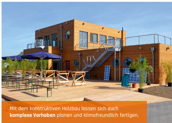
Schnell, flexibel und nach modernstem energetischen Standard - viele Gründe sprechen für einen An- oder Umbau mit Holz.
